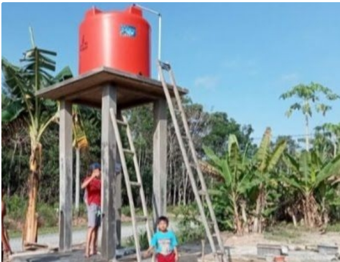
Pembangunan sumur bor di Desa Fajar Baru
